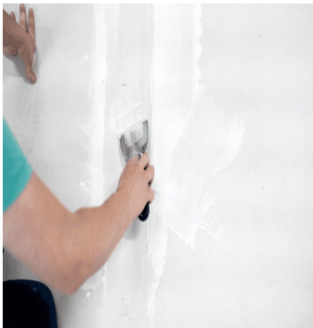
Juntas en placas de yeso laminado
