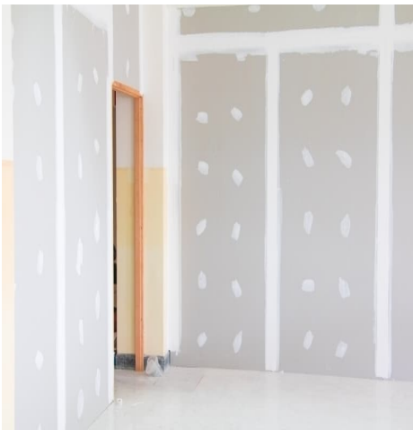
Juntas en placas de yeso laminado
