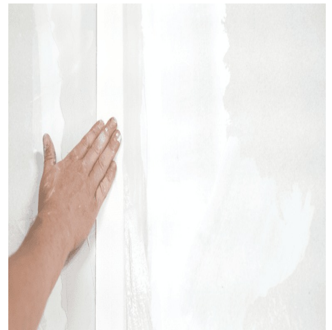
Juntas en placas de yeso laminado
